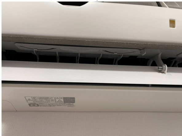
15.エアコンクリーニング
