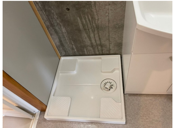
7.洗濯機防水パン
