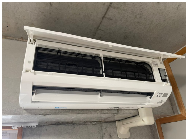
15.エアコンクリーニング
