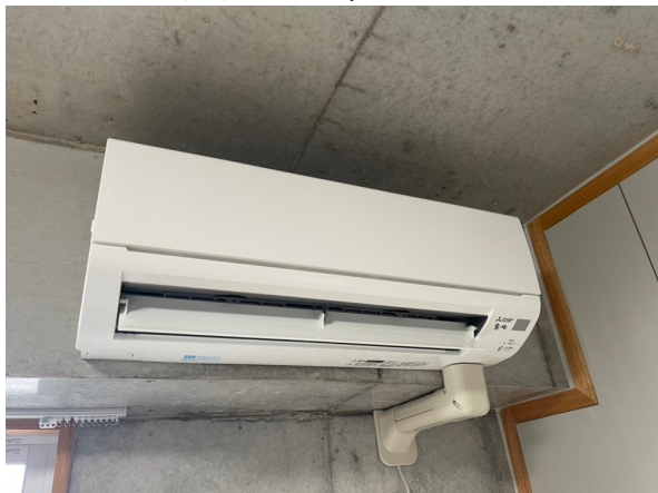
15.エアコンクリーニング
