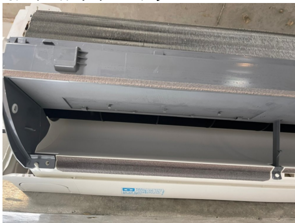
15.エアコンクリーニング
