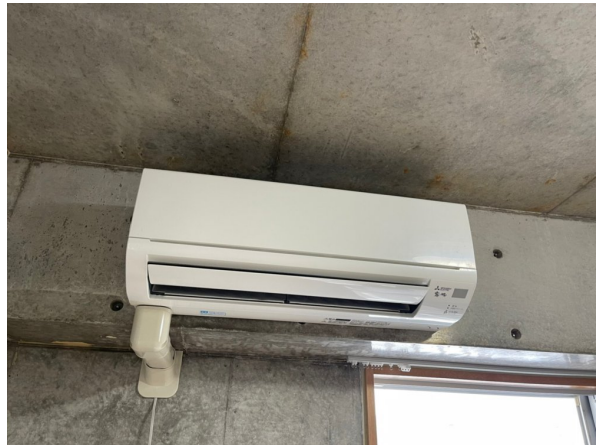
14.エアコンクリーニング
