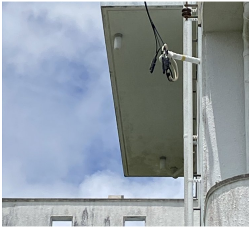
共用灯電球取替(廊下側)
