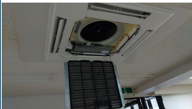
9.エアコンクリーニング
