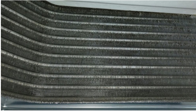
9.エアコンクリーニング
