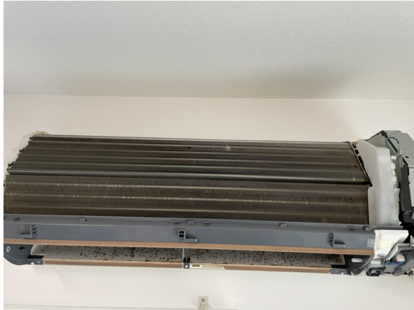
15.エアコンクリーニング
