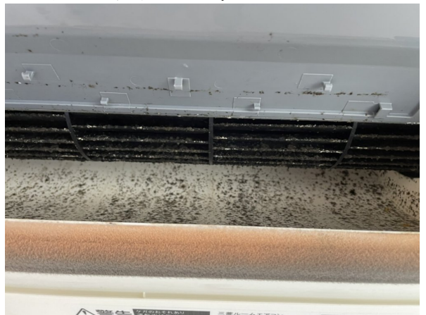
15.エアコンクリーニング
