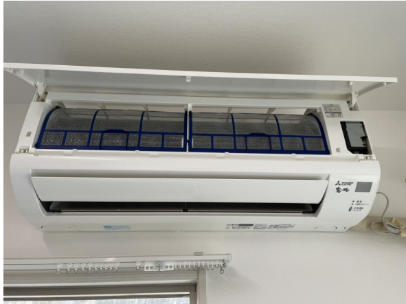
15.エアコンクリーニング
