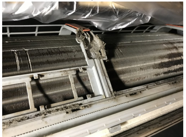
1.エアコンクリーニング
