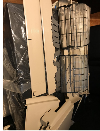
1.エアコンクリーニング
