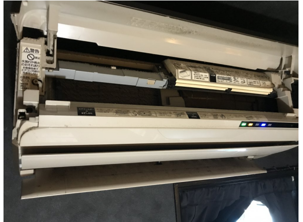
1.エアコンクリーニング
