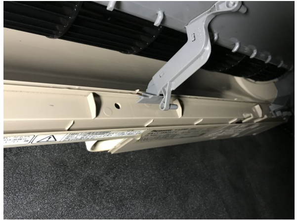
1.エアコンクリーニング
