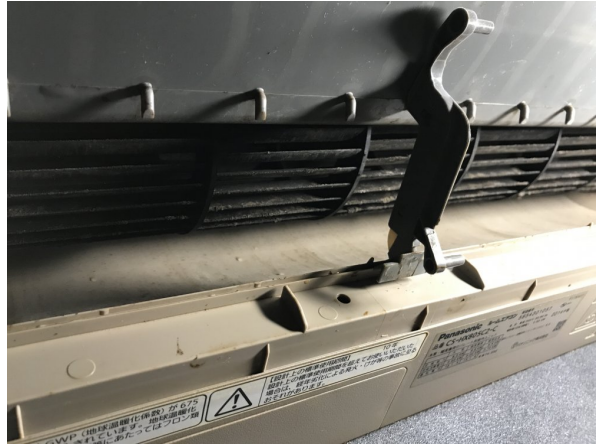
1.エアコンクリーニング
