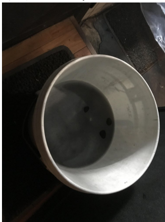
1.エアコンクリーニング
