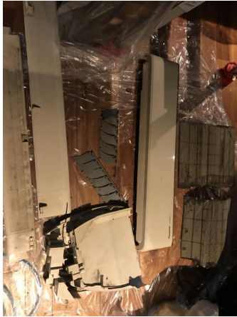
1.エアコンクリーニング
