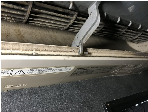
1.エアコンクリーニング
