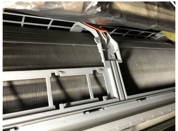
1.エアコンクリーニング
