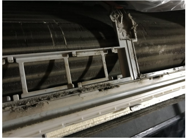
1.エアコンクリーニング
