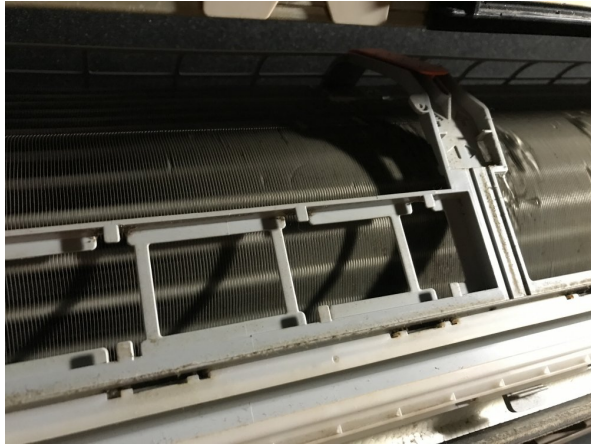
1.エアコンクリーニング
