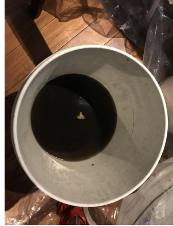
1.エアコンクリーニング
