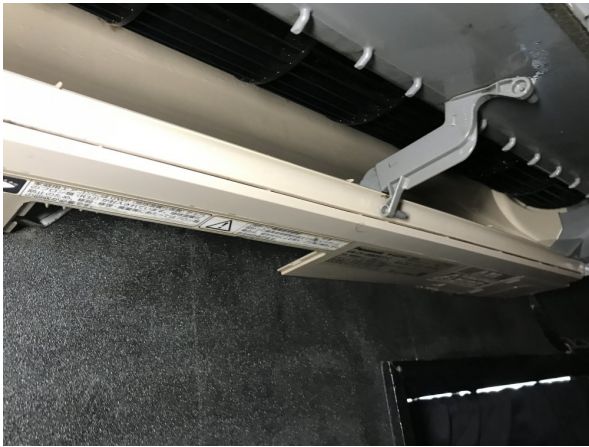
1.エアコンクリーニング
