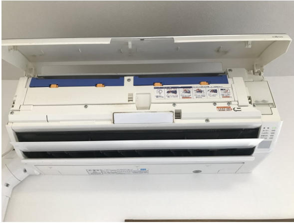
14.エアコンクリーニング
