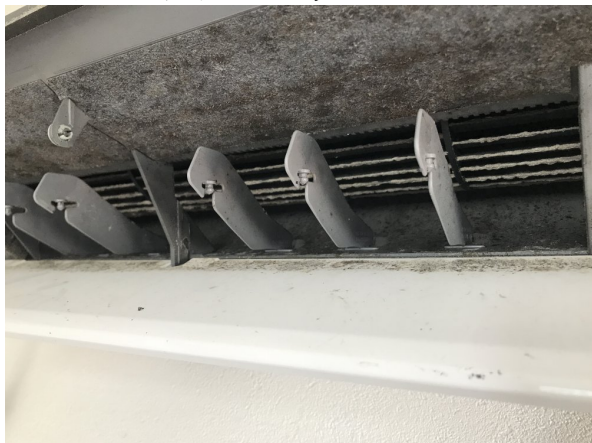
14.エアコンクリーニング
