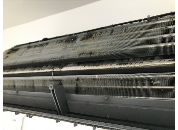
14.エアコンクリーニング
