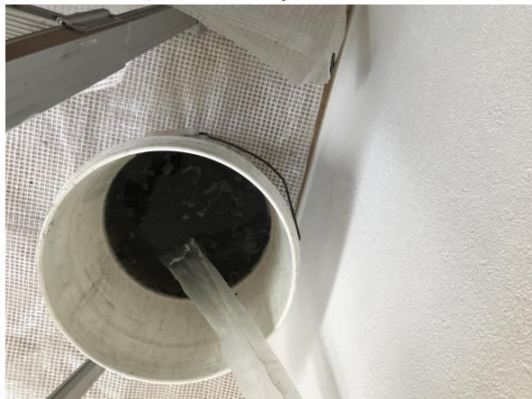
14.エアコンクリーニング
