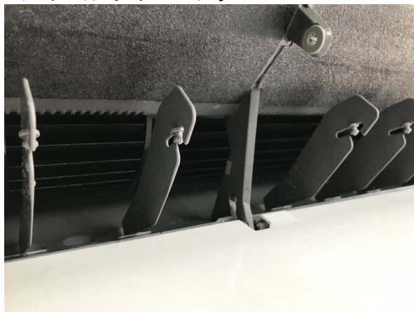
14.エアコンクリーニング
