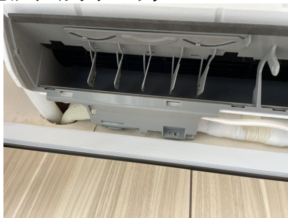
14.エアコンクリーニング
