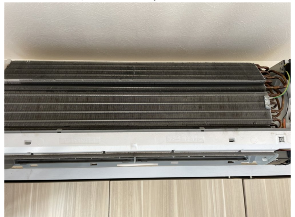
14.エアコンクリーニング
