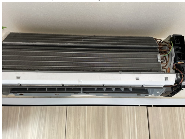
14.エアコンクリーニング
