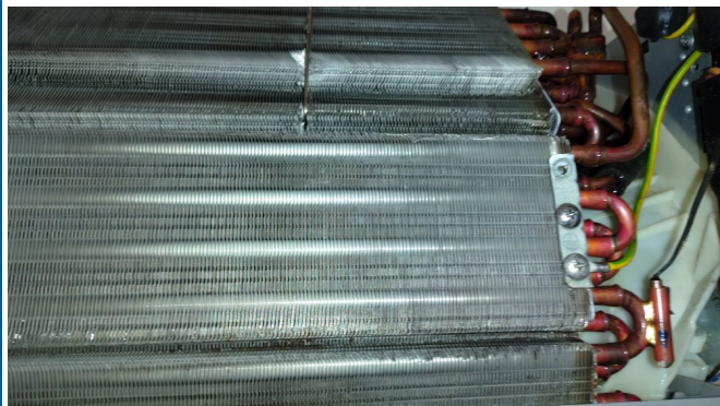
11.エアコンクリーニング
