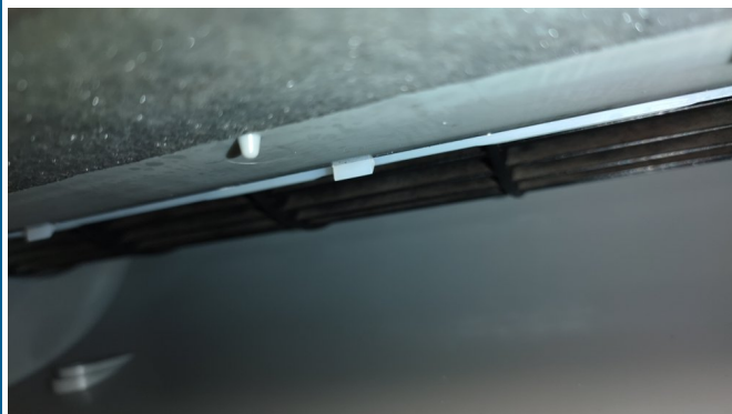
11.エアコンクリーニング
