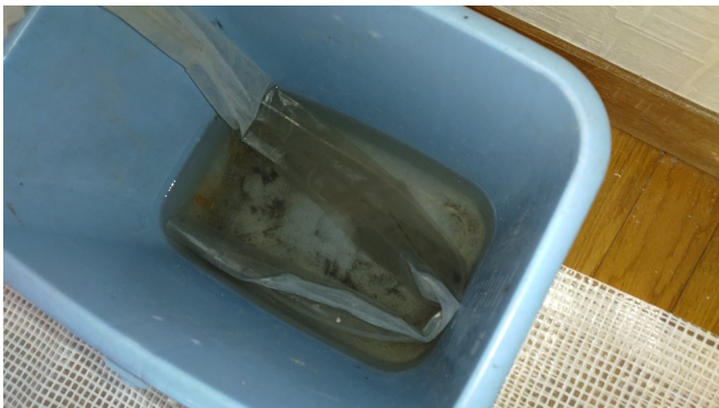
11.エアコンクリーニング
