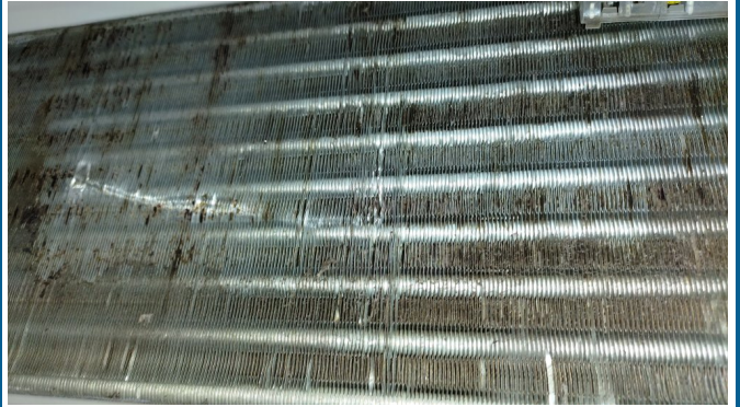
11.エアコンクリーニング
