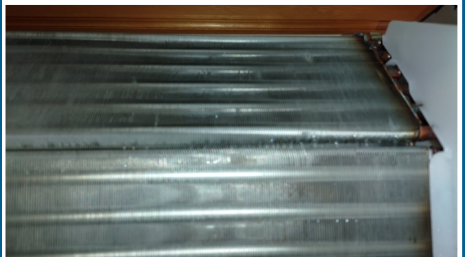
12.エアコンクリーニング
