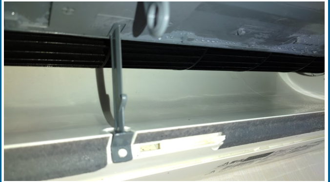
12.エアコンクリーニング
