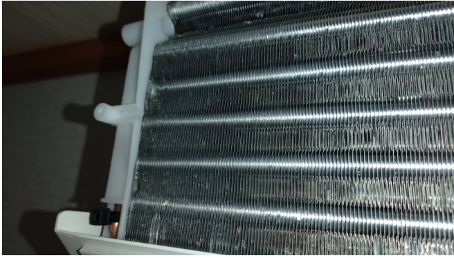
12.エアコンクリーニング
