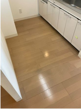
24.床剥離洗浄after
