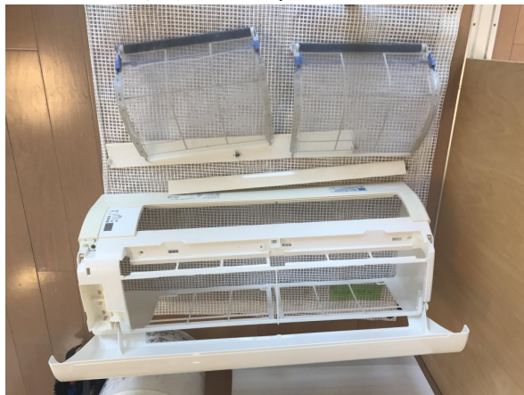
15.エアコンクリーニング
