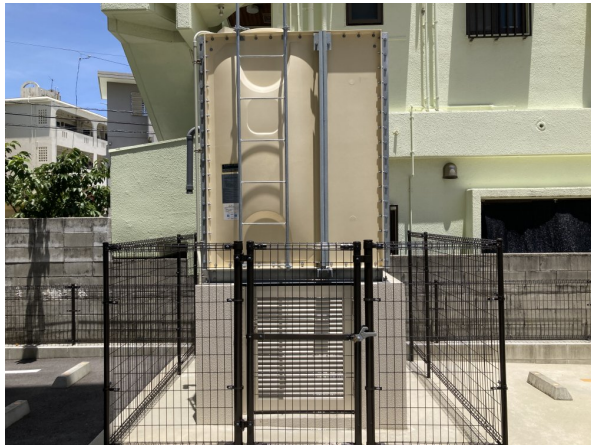
2.受水槽フェンスまわり
