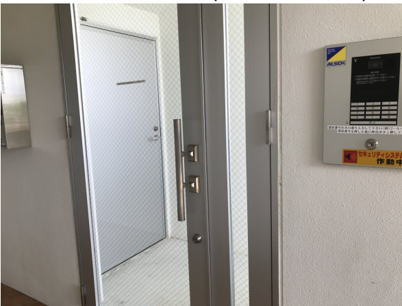
4.エントランスホール（タイル・ガラス）
