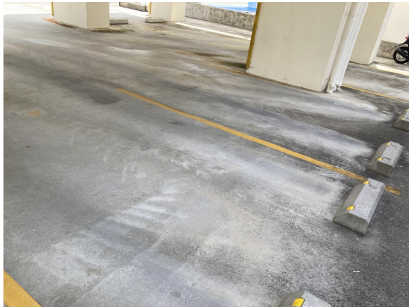
1. 駐車場・駐輪場
