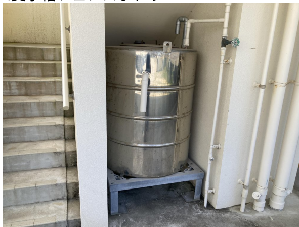
2. 受水槽フェンスまわり
