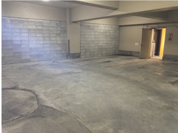
1. 駐車場・駐輪場
