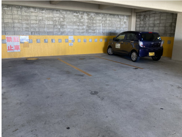
1. 駐車場・駐輪場
