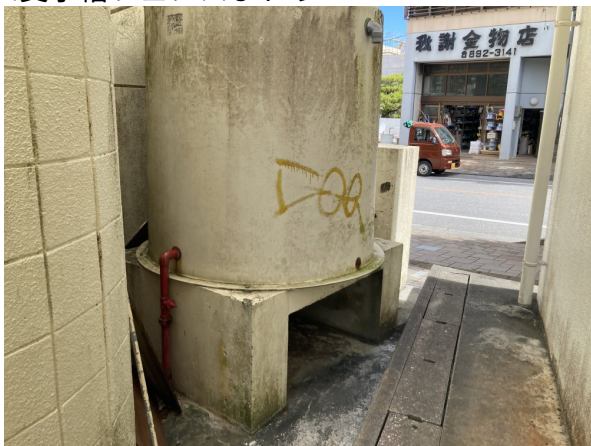
2. 受水槽フェンスまわり
