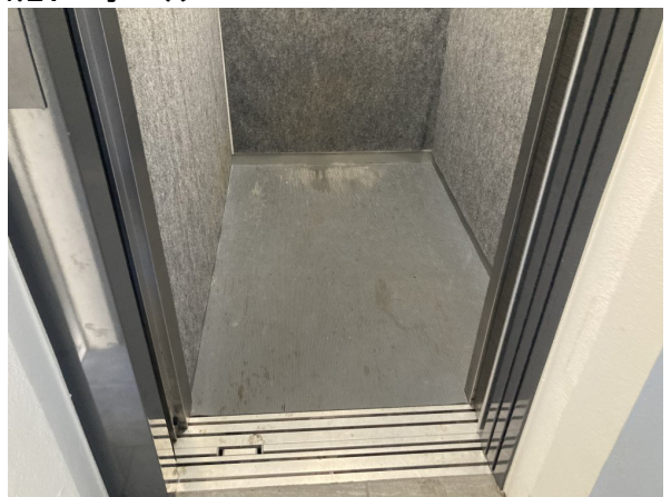
4.EV・ホール
