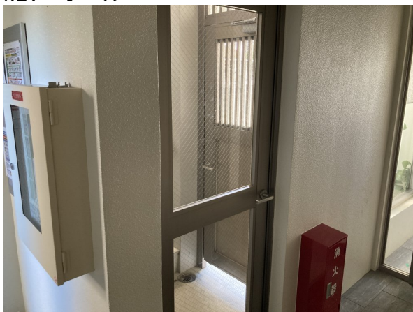
4.EV・ホール
