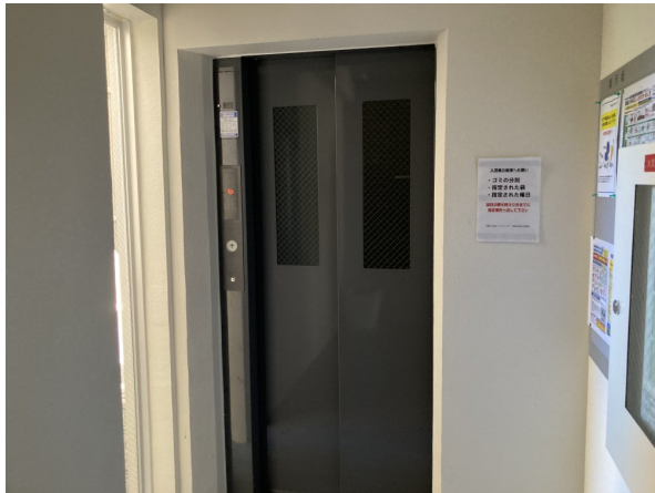
4.EV・ホール
