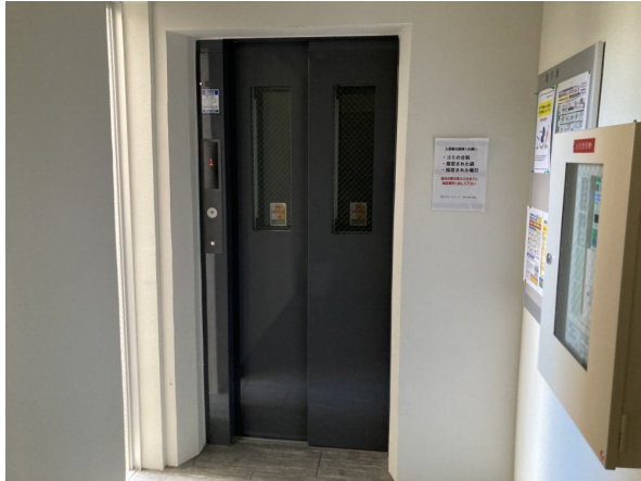
4.EV・ホール
