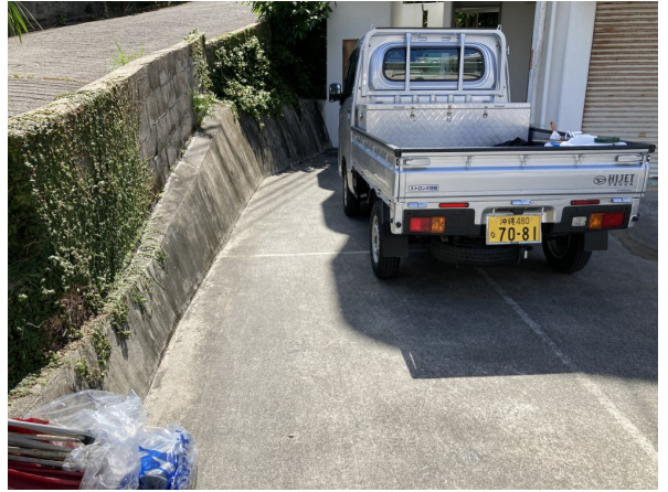
1. 駐車場・駐輪場
