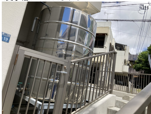
2. 受水槽フェンスまわり
