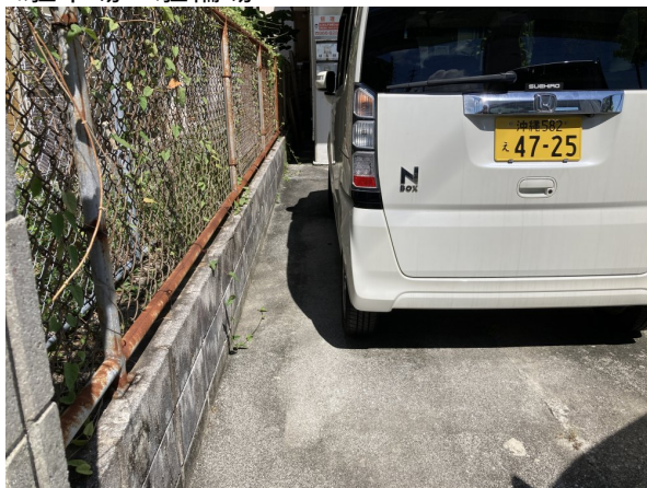
1. 駐車場・駐輪場
