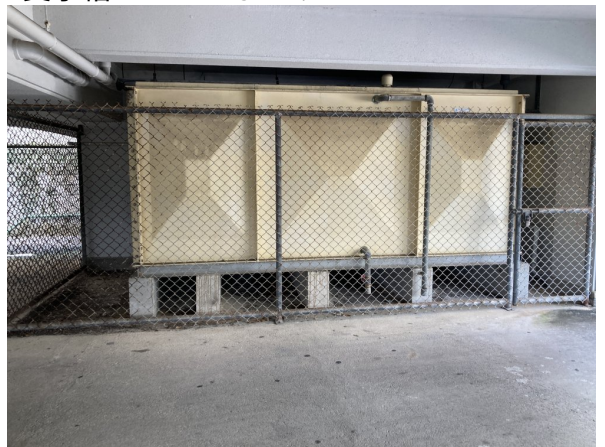
2. 受水槽フェンスまわり
