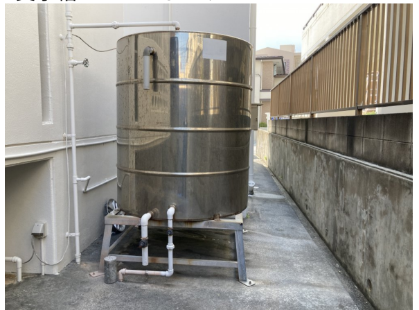
2. 受水槽フェンスまわり
