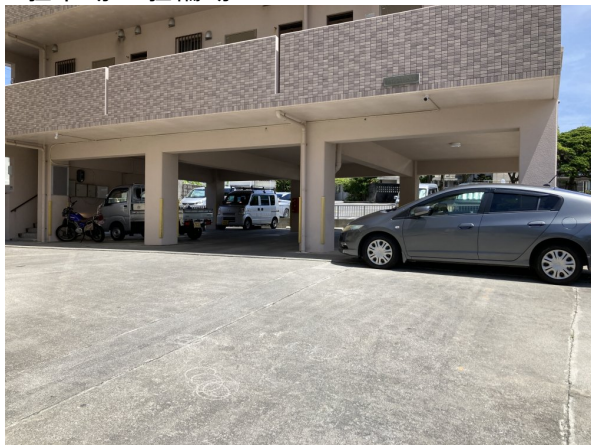
1. 駐車場・駐輪場
