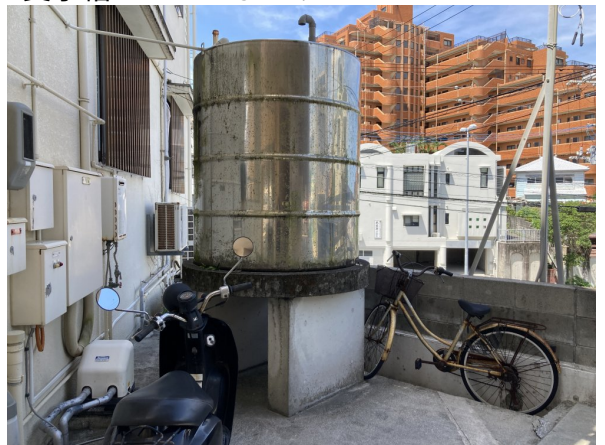
2. 受水槽フェンスまわり
