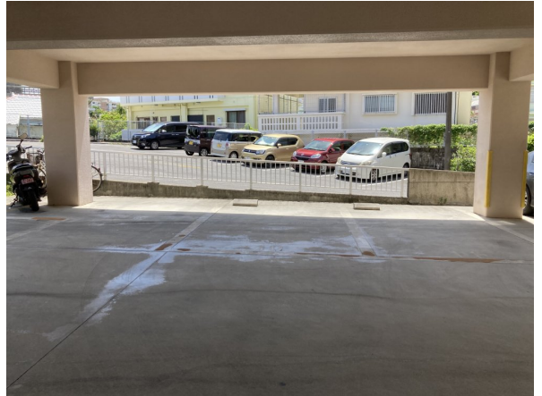
1. 駐車場・駐輪場
