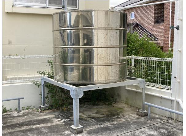
2. 受水槽フェンスまわり
