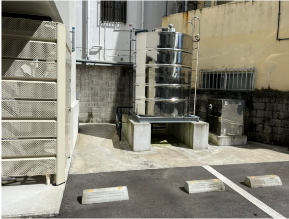
6.受水槽フェンスまわり
