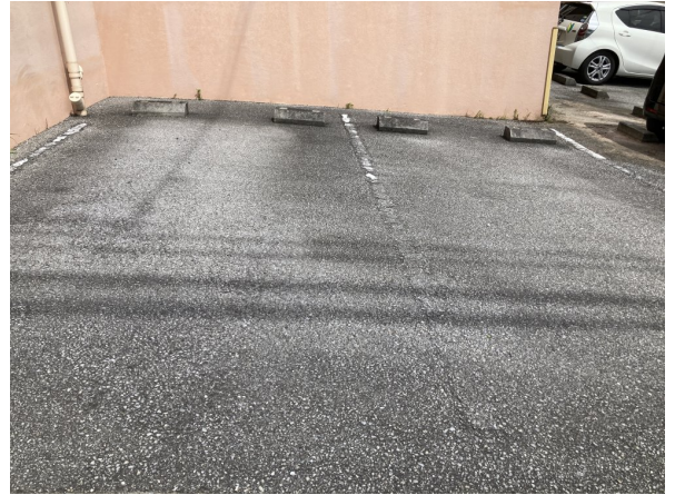
7. 駐車場・駐輪場
