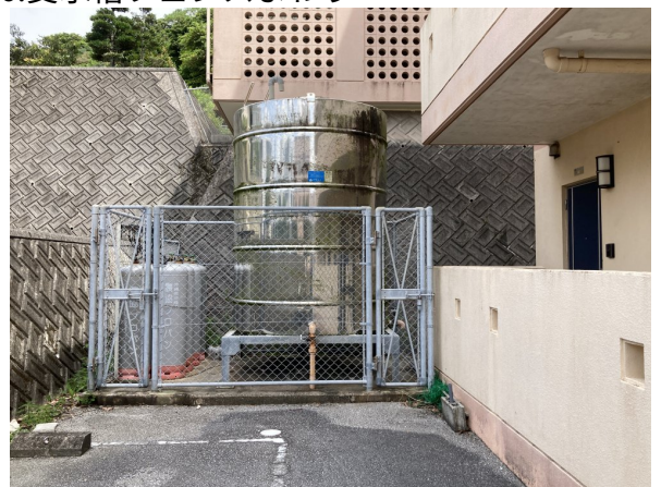
6.受水槽フェンスまわり
