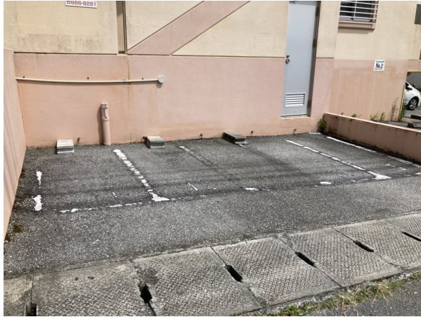
7. 駐車場・駐輪場
