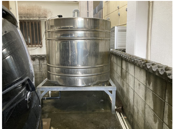
2. 受水槽フェンスまわり
