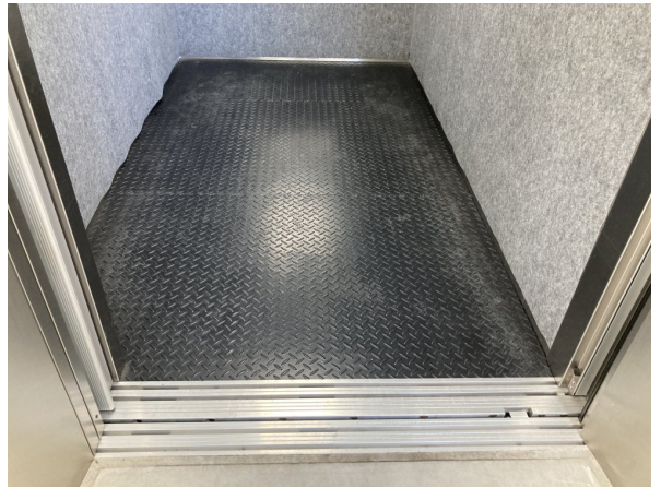
2.EV・ホール
