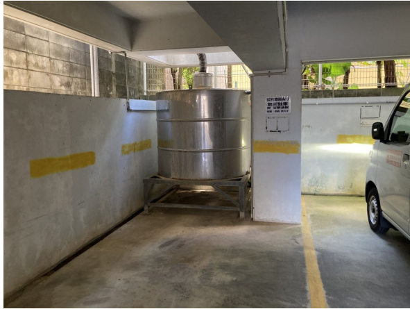
2. 受水槽フェンスまわり
