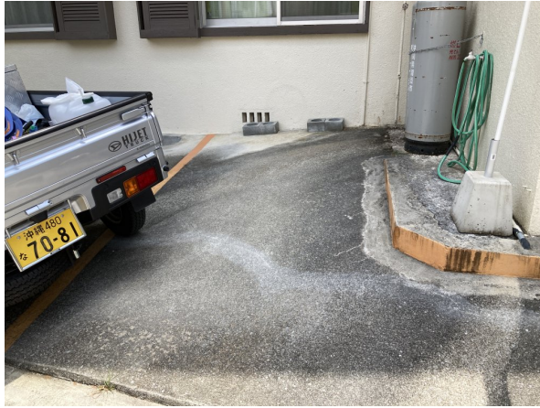
1. 駐車場・駐輪場
