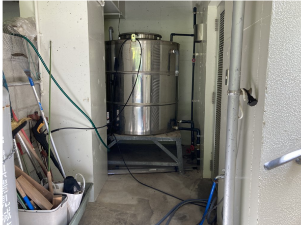
2.受水槽フェンスまわり
