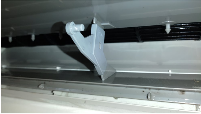
17.エアコンクリーニング
