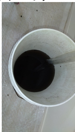
17.エアコンクリーニング
