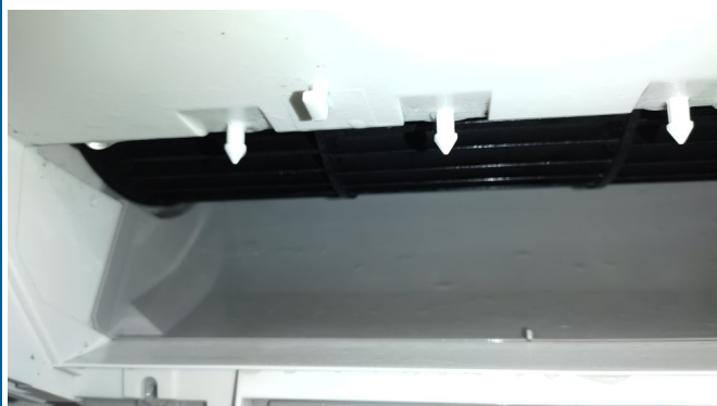
17.エアコンクリーニング
