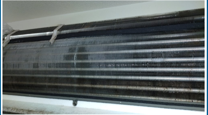
17.エアコンクリーニング
