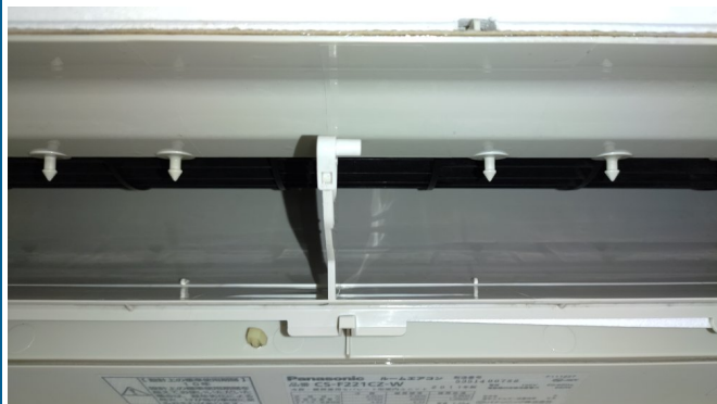
17.エアコンクリーニング
