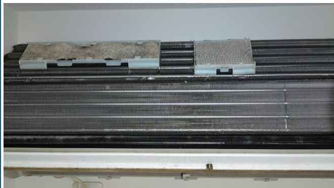
17.エアコンクリーニング
