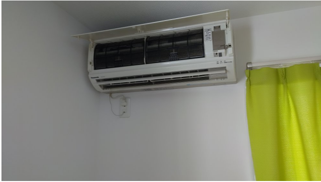
17.エアコンクリーニング
