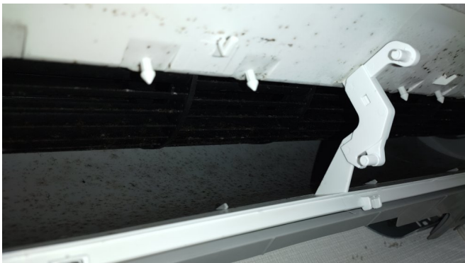
17.エアコンクリーニング
