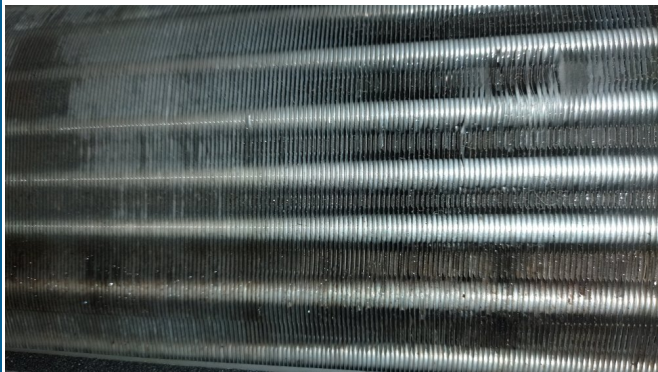
17.エアコンクリーニング
