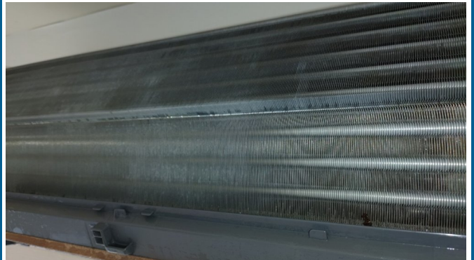
13.エアコンクリーニング
