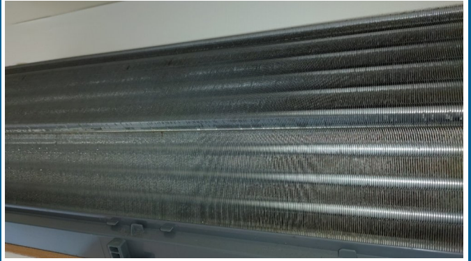
13.エアコンクリーニング
