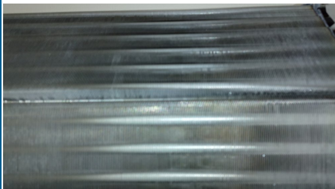
13.エアコンクリーニング
