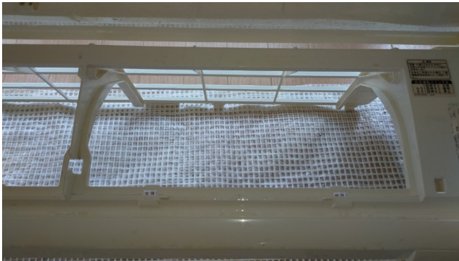
13.エアコンクリーニング
