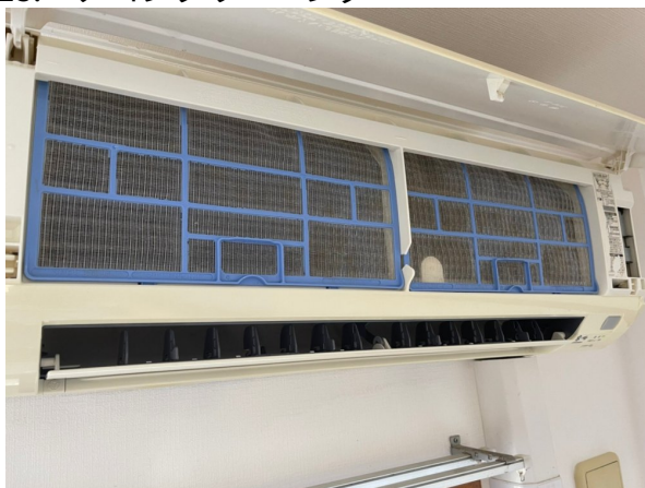
13.エアコンクリーニング
