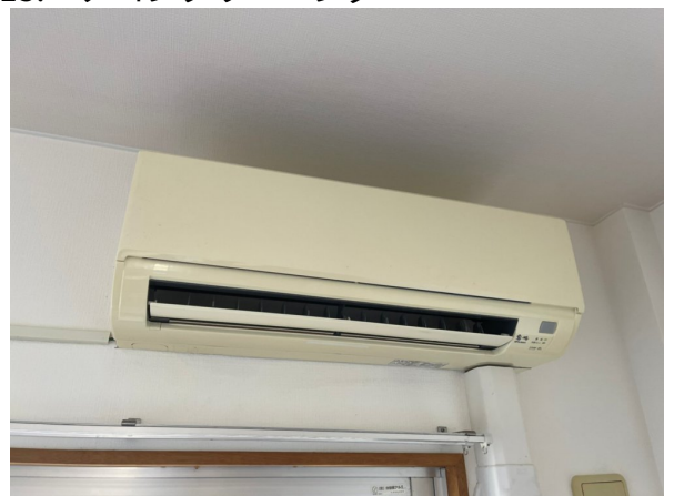
13.エアコンクリーニング
