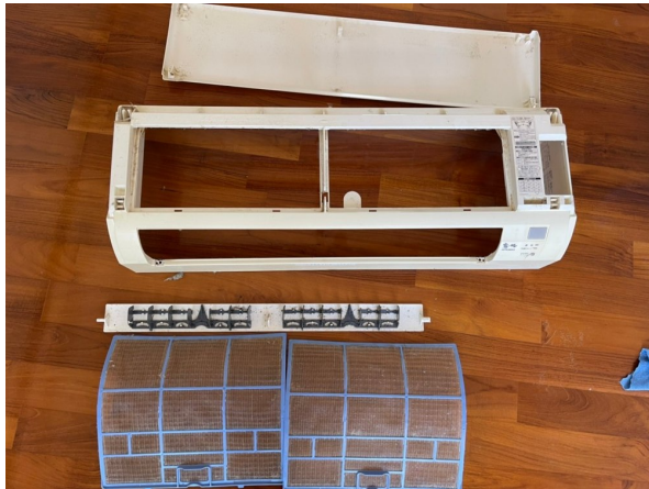
13.エアコンクリーニング
