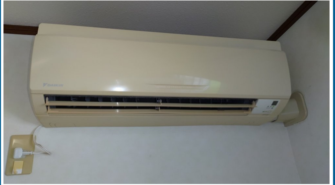
1.エアコンクリーニング
