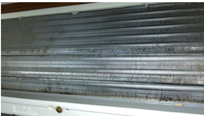
1.エアコンクリーニング
