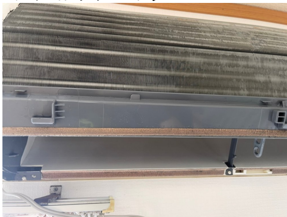
14.エアコンクリーニング
