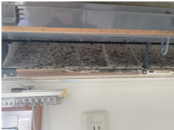
14.エアコンクリーニング
