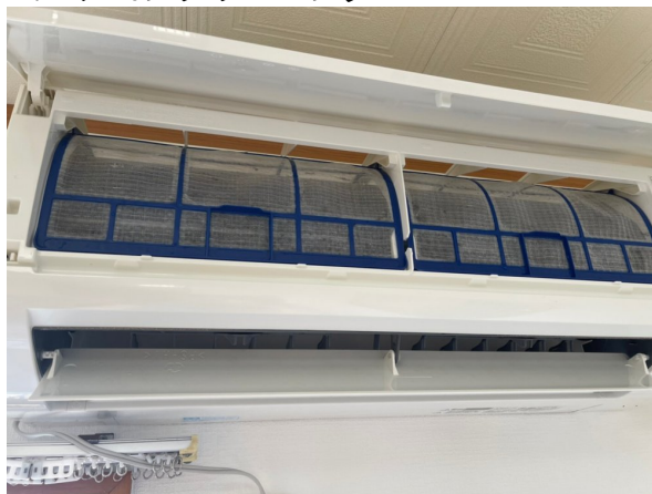
14.エアコンクリーニング
