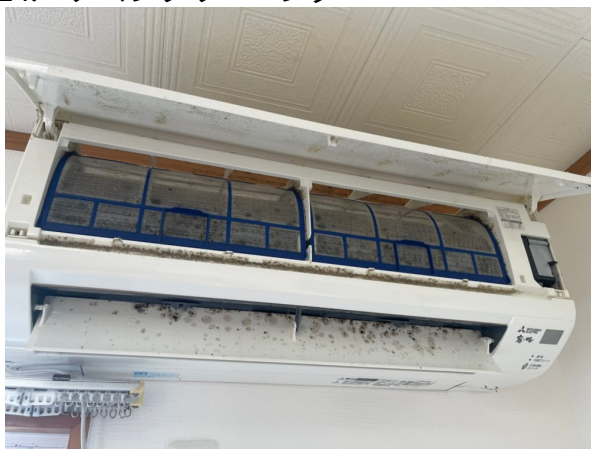
14.エアコンクリーニング
