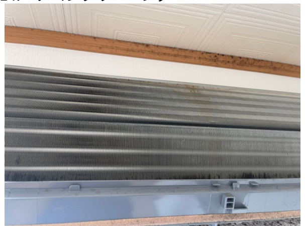
14.エアコンクリーニング
