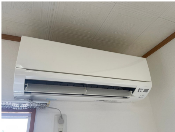
14.エアコンクリーニング
