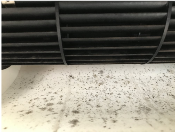
13.エアコンクリーニング
