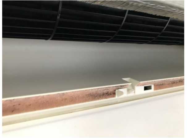
13.エアコンクリーニング
