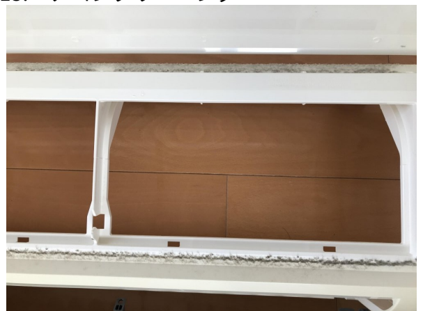
13.エアコンクリーニング
