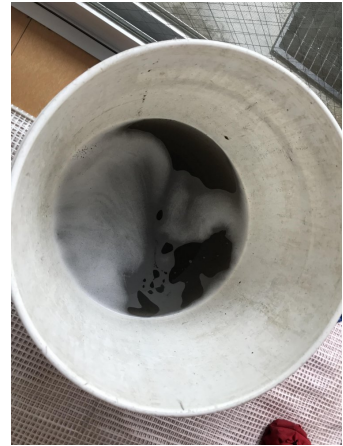
13.エアコンクリーニング
