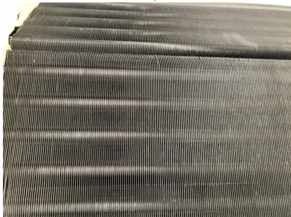
13.エアコンクリーニング
