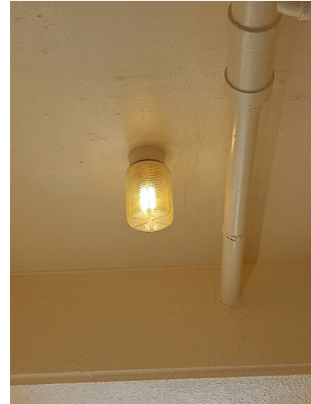
301号・202号室玄関前 スパイラル球取替済み 口金E26
