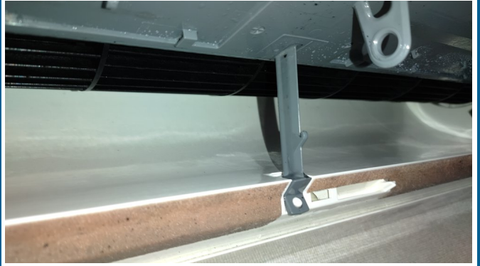
12.エアコンクリーニング
