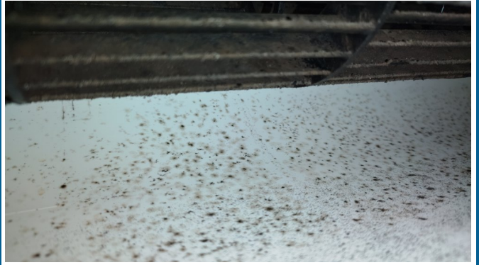
12.エアコンクリーニング
