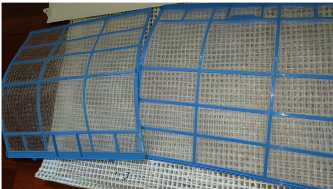
12.エアコンクリーニング
