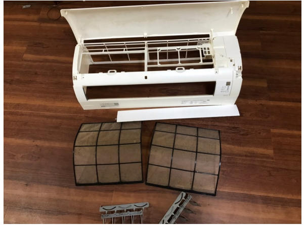
11.エアコンクリーニング
