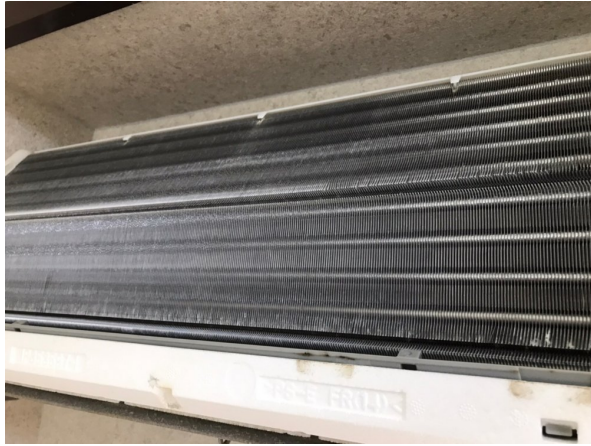
11.エアコンクリーニング
