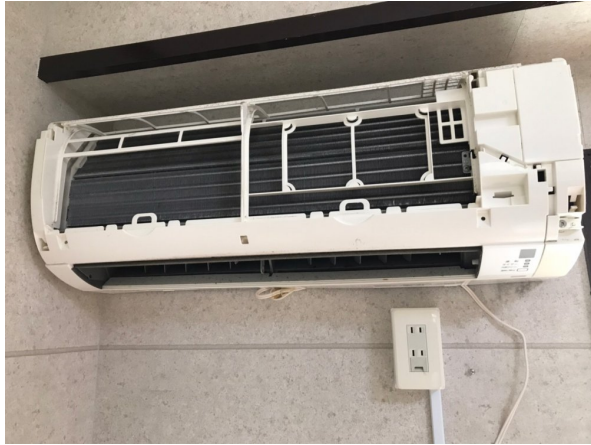
11.エアコンクリーニング
