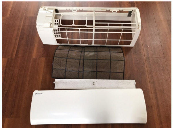
11.エアコンクリーニング
