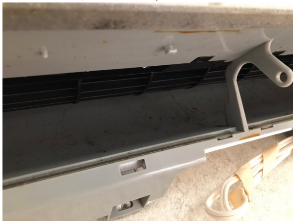
11.エアコンクリーニング
