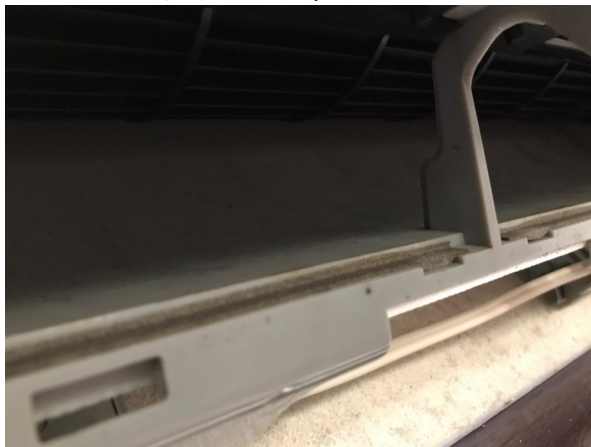
11.エアコンクリーニング
