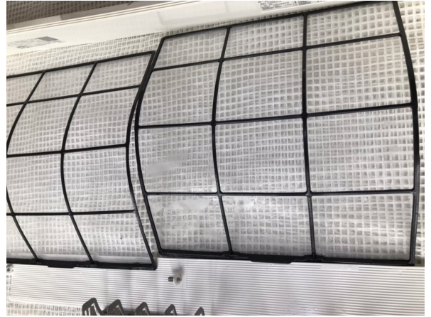
11.エアコンクリーニング
