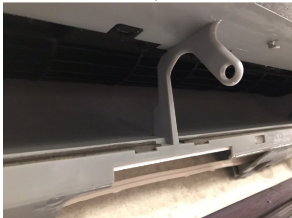
11.エアコンクリーニング
