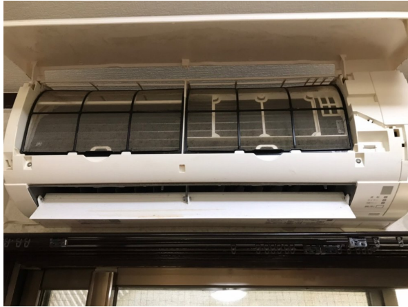
11.エアコンクリーニング
