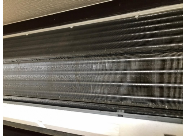
11.エアコンクリーニング
