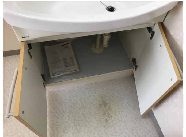
洗面化粧台底板張替すみ
