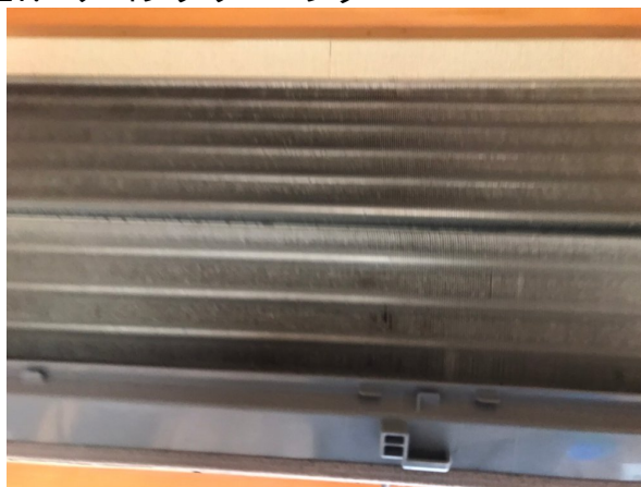
17.エアコンクリーニング
