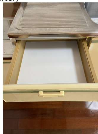
流し台引き出し底板補修 after
