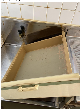
流し台引き出し底板補修 before
