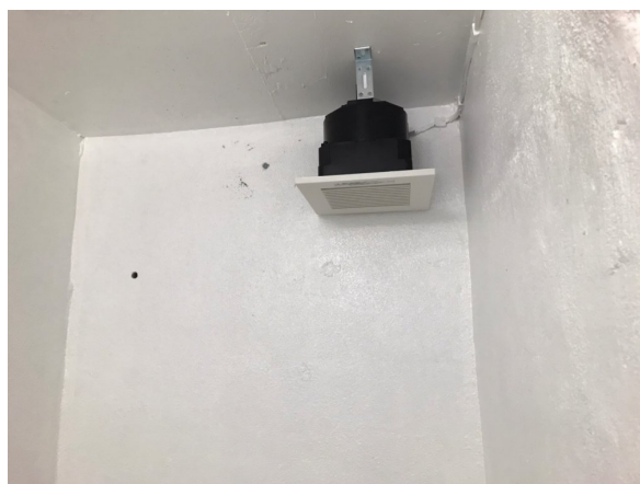
風呂場・トイレ壁換気扇取付工事 済み
