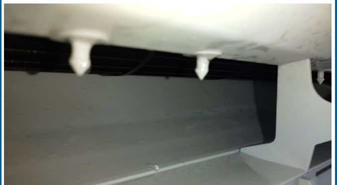
17.エアコンクリーニング
