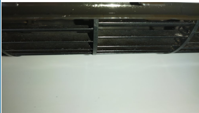
14.エアコンクリーニング
