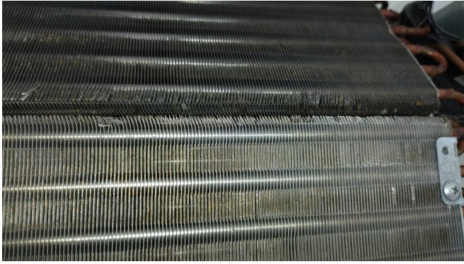
14.エアコンクリーニング
