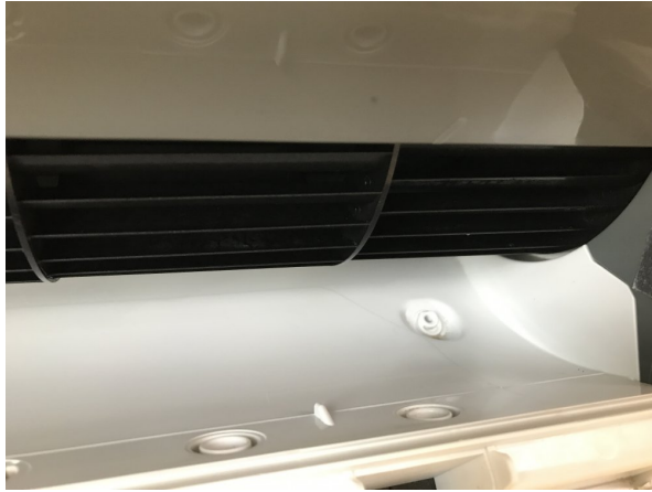
12.エアコンクリーニング
