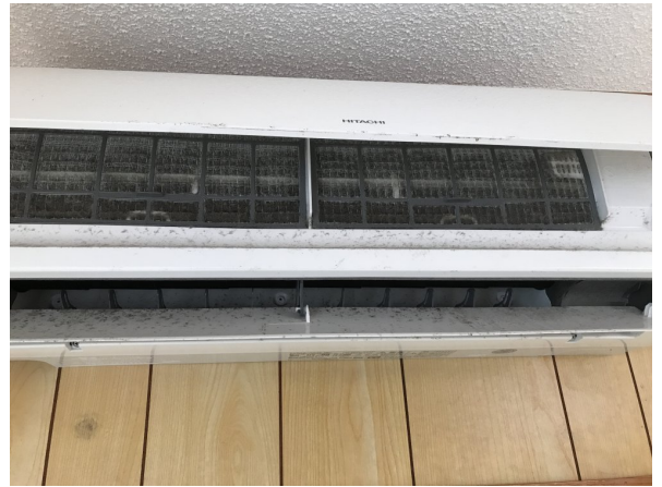
12.エアコンクリーニング
