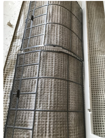
12.エアコンクリーニング
