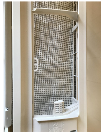
12.エアコンクリーニング
