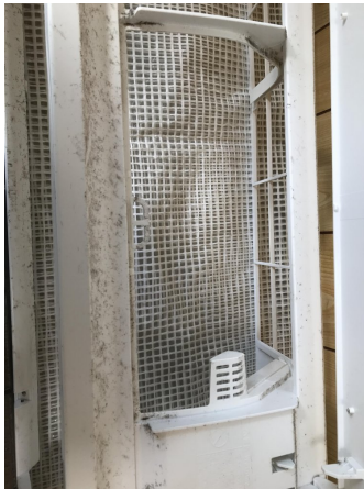
12.エアコンクリーニング
