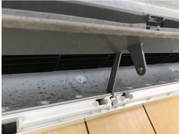
12.エアコンクリーニング
