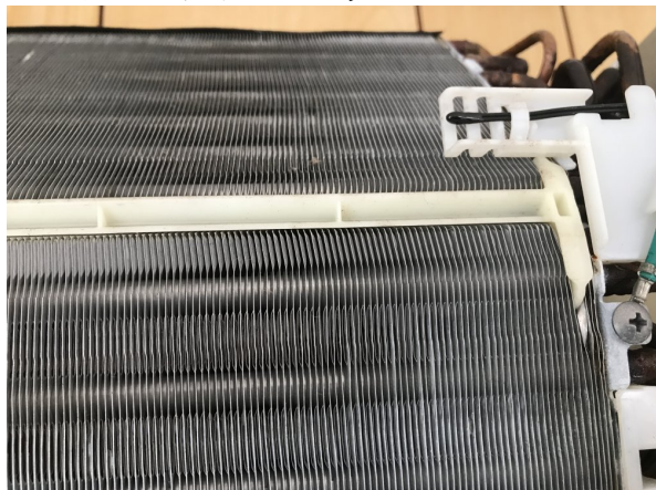
12.エアコンクリーニング
