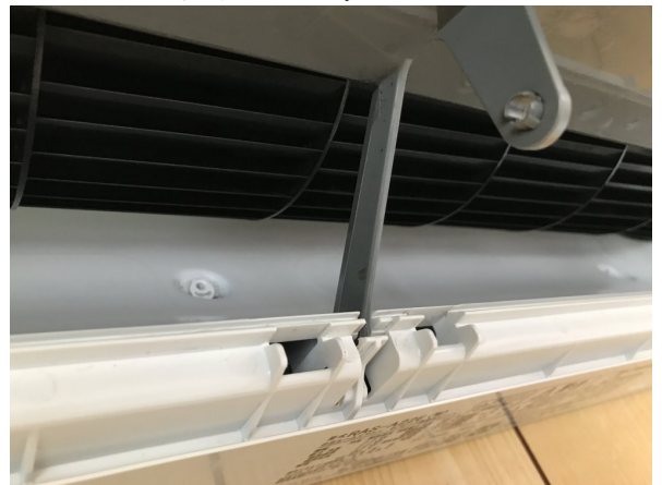
12.エアコンクリーニング
