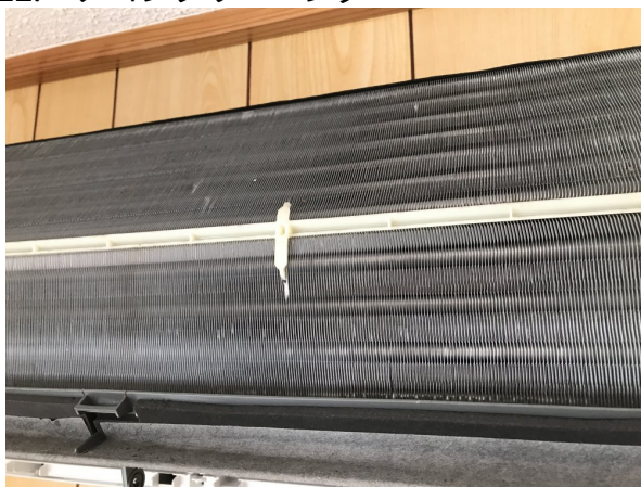
12.エアコンクリーニング
