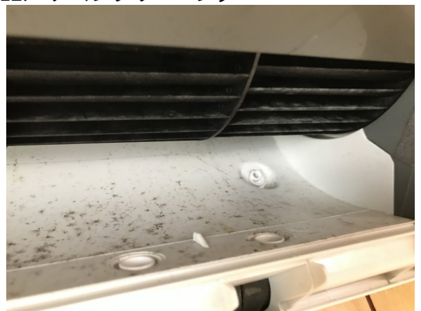
12.エアコンクリーニング
