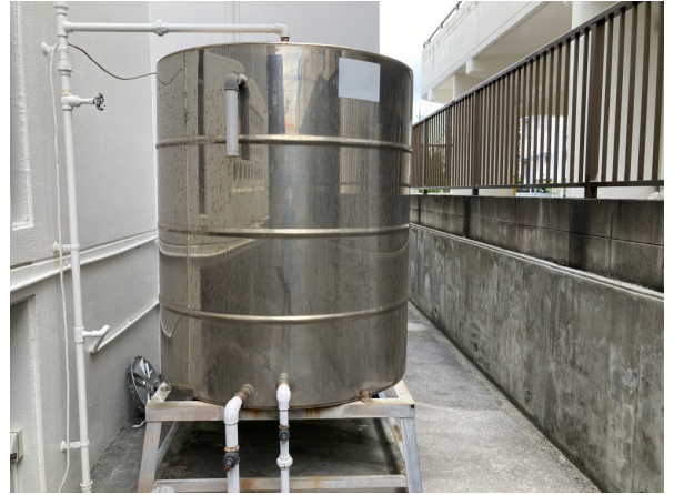
2. 受水槽フェンスまわり
