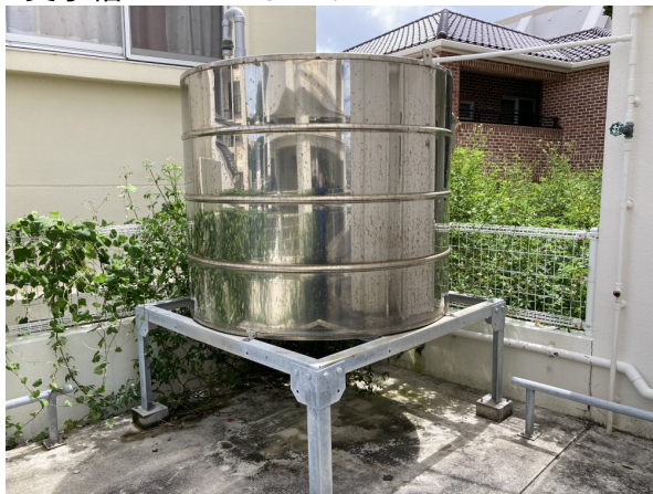
2. 受水槽フェンスまわり
